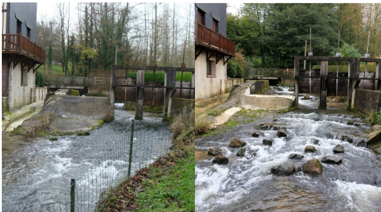
Figure 94 : Moulin Rica avant et après travaux (FDAAPPMA27)
