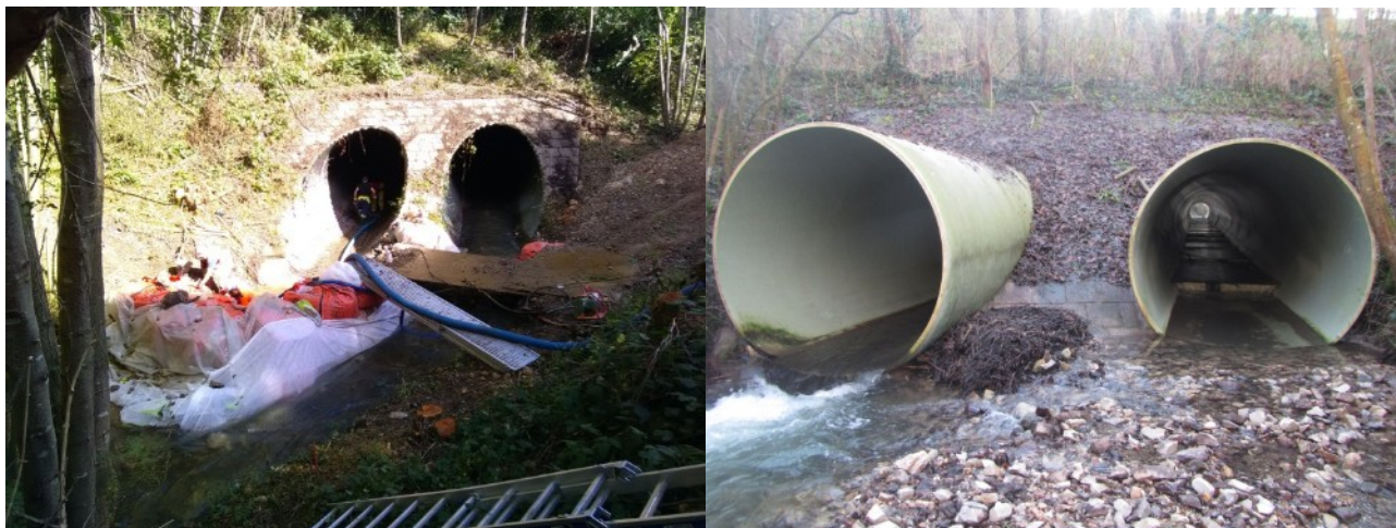
Figure 118 : Dispositif de franchissement installé dans les buses de franchissement de l'autoroute A13 (FDAAPPMA27)
