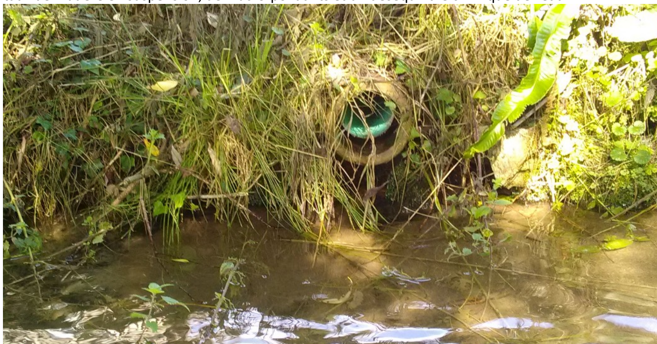
Figure 110 : Rejet direct supposé domestique observé sur les Godeliers (FDAAPPMA27)
